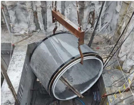
图 4 新型管道吊装专用吊具应用效果图
