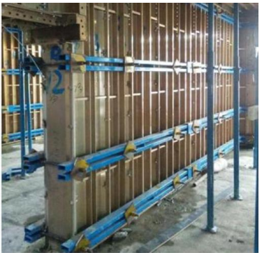
图 5 现场墙板安装图
