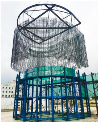
图2 钢筋整体绑扎及吊装
