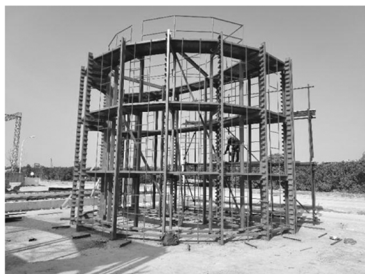
图 6 钢筋绑扎平台
