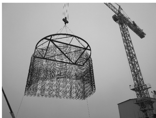
图 8 钢筋骨架吊装
