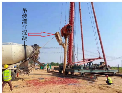
图 5 吊装灌注混凝土
