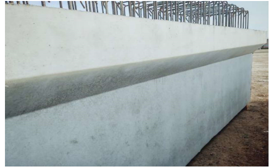
图 2 喷洒养护液及覆膜养护效果
