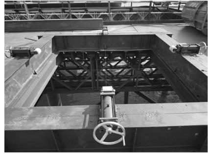
图 2 单层导向架安装
