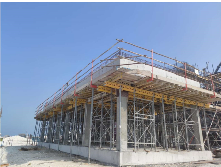
图4 PERI模板安装示意图
