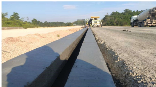
图 3 缝隙式集水沟滑模施工现场
