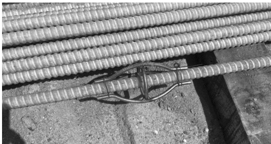
图 4 玻璃纤维筋对中定位支架
