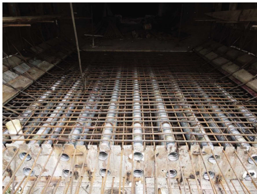
图 1 预应力管道接长安装
