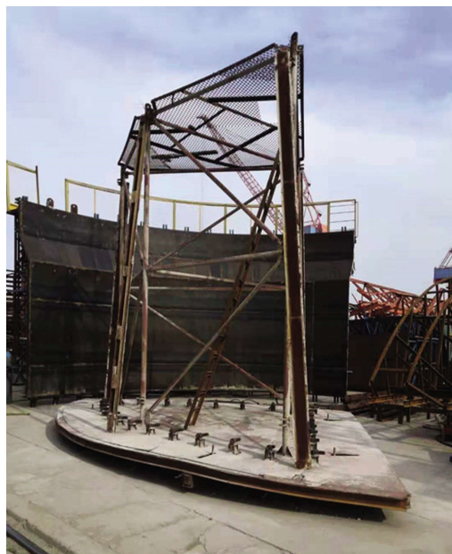
图2 圆形沉箱芯模吊装平台
